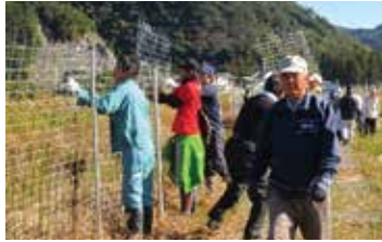
野生動物の侵入防止柵設置の様子
